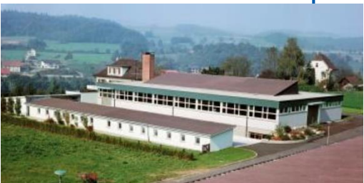
Bau des ersten grossen Fabrikgebäudes
