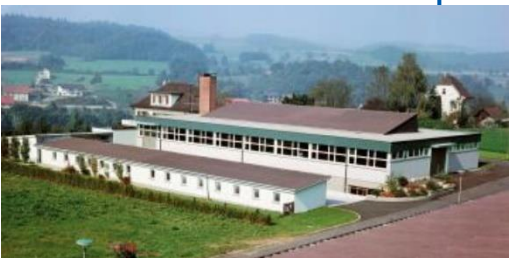
Bau des ersten grossen Fabrikgebäudes
