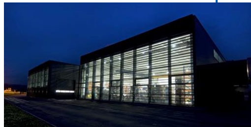
Erweiterung der Fertigung um das Werk 4
